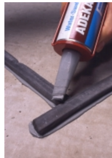
ADEKA-Fugenband in Kombination mit P-201
